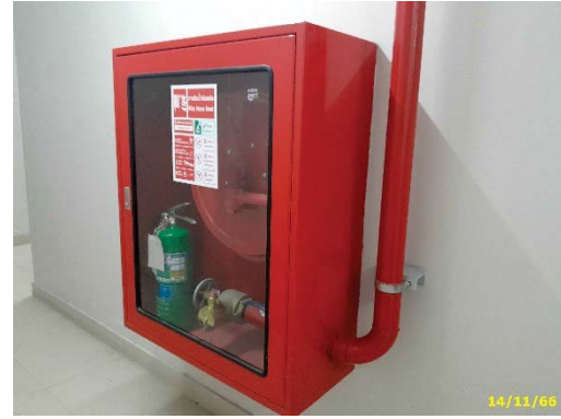
ตู้เก็บสายฉีดน้ำดับเพลิงพร้อมอุปกรณ์ และป้ายแนะนำ การใช้งาน
